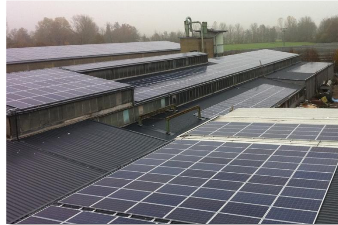
Halle 3: Dachfläche saniert und mit PV-Modulen belegt.
