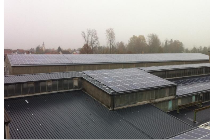
Halle 9 im Hintergrund: Dachfläche saniert und mit PV-Modulen belegt.
