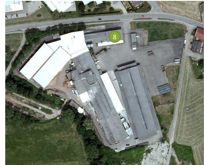
● Gebäude 8 Bürogebäude für Entwicklung und Konstruktion
